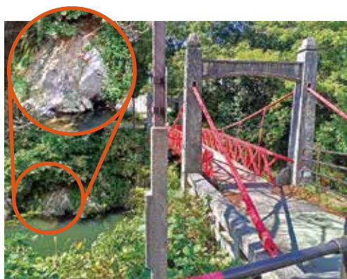
▲ 岩堰橋の下に残る開削の跡
