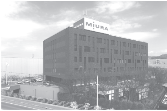
三浦工業本社ビル（松山市堀江町）
